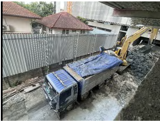
ภาพที่ 2.2-6 การปิดคลุมด้วยผ้าใบของรถบรรทุก
