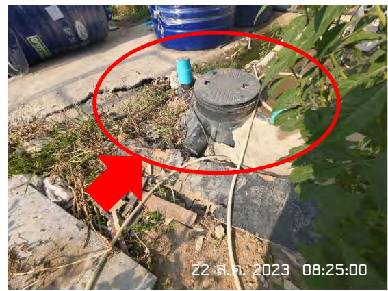
ภาพที่ 2.2-13 ถึงบำบัดน้ำเสียในพื้นที่บ้านพัก คนงาน
