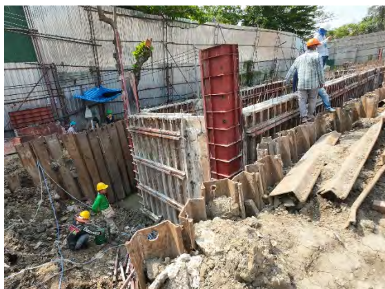
ภาพที่ 2.2-10 แนว Sheet Pile
