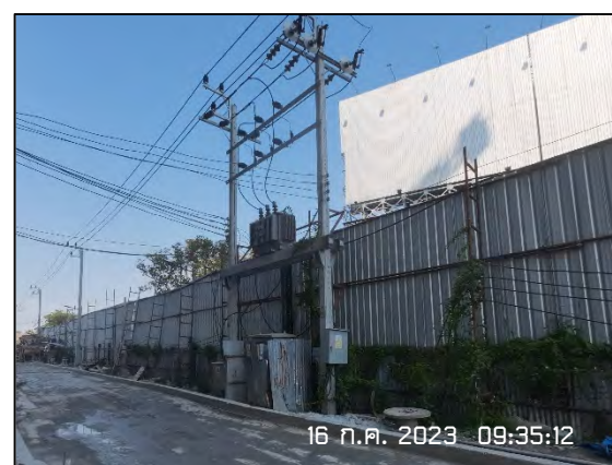
ภาพที่ 2.2-16 หม้อแปลงไฟฟ้าภายในโครงการ
